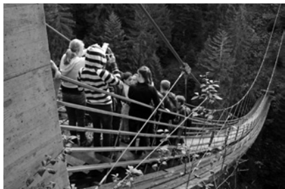
Vor dem Abgrund: Der Traversinersteg geht in Mark und Bein.
